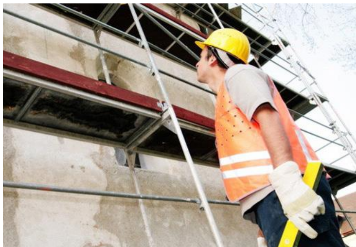
Fig. 10. hausinfo.ch... sécurité sur les chantiers 30
