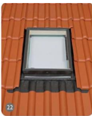
La fenêtre de toit terminée
